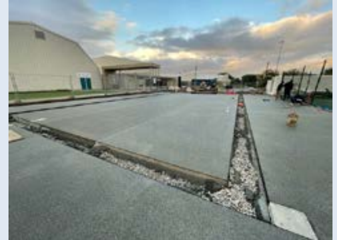
Dallage béton poreux
