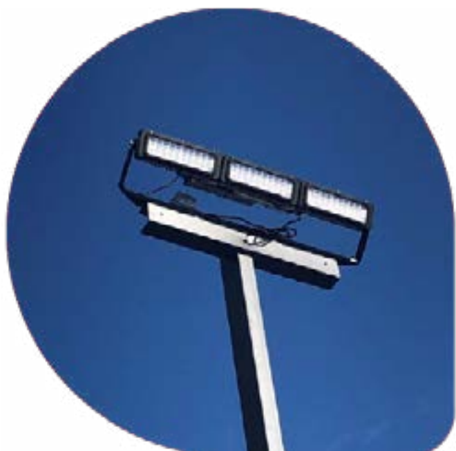
Projecteurs LED 3x320 Watts asymétriques ( dernière génération).
