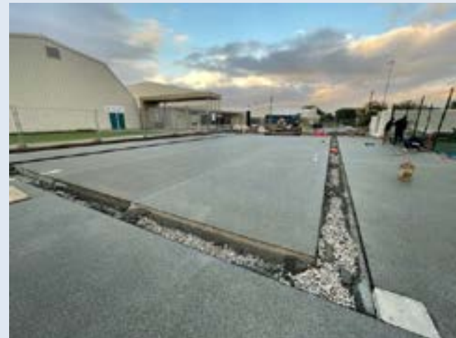
Dallage béton poreux
