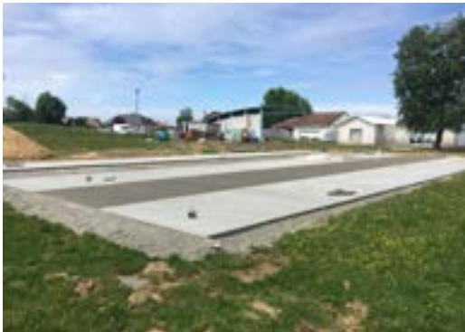
Dallage béton poreux
