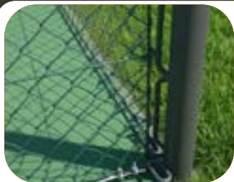
Poteau d'angle avec barre de maintien soudée
