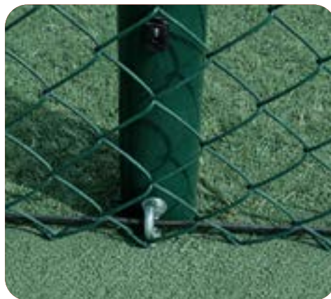
Boucle inox à visser en partie basse (de série) en partie basse
