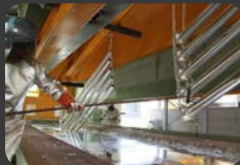
Structure galvanisée à chaud
