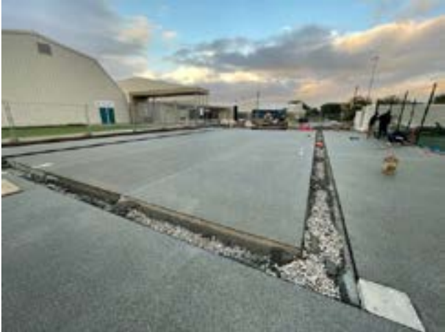
Dallage béton poreux
