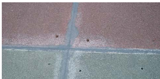
Perçage du support en béton poreux si nécessaire
