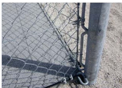
Poteau d'angle avec barre de maintien soudée.
